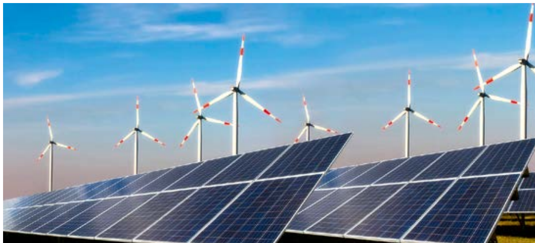
Photovoltaik- und Windkraftanlage in Deutschland
